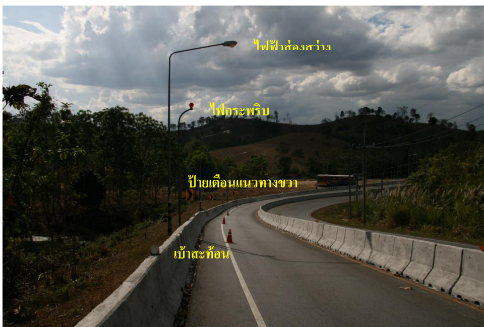
รูปที่ 3-22 อุปกรณ์ถนนใหม่บริเวณที่เกิดเหตุ
