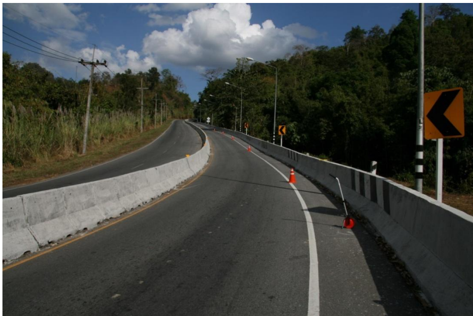
รูปที่ 3-18 สภาพถนนในช่วงบริเวณที่เกิดเหตุ
