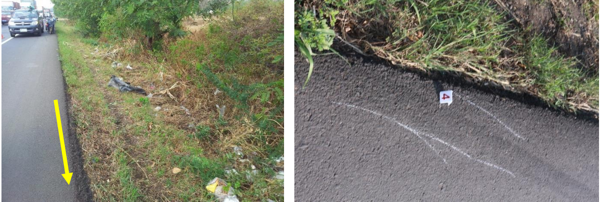
รูปที่ 26 รอยล้อ (ความยาว 7 เมตร) บริเวณขอบของไหล่ทางด้านนอก
