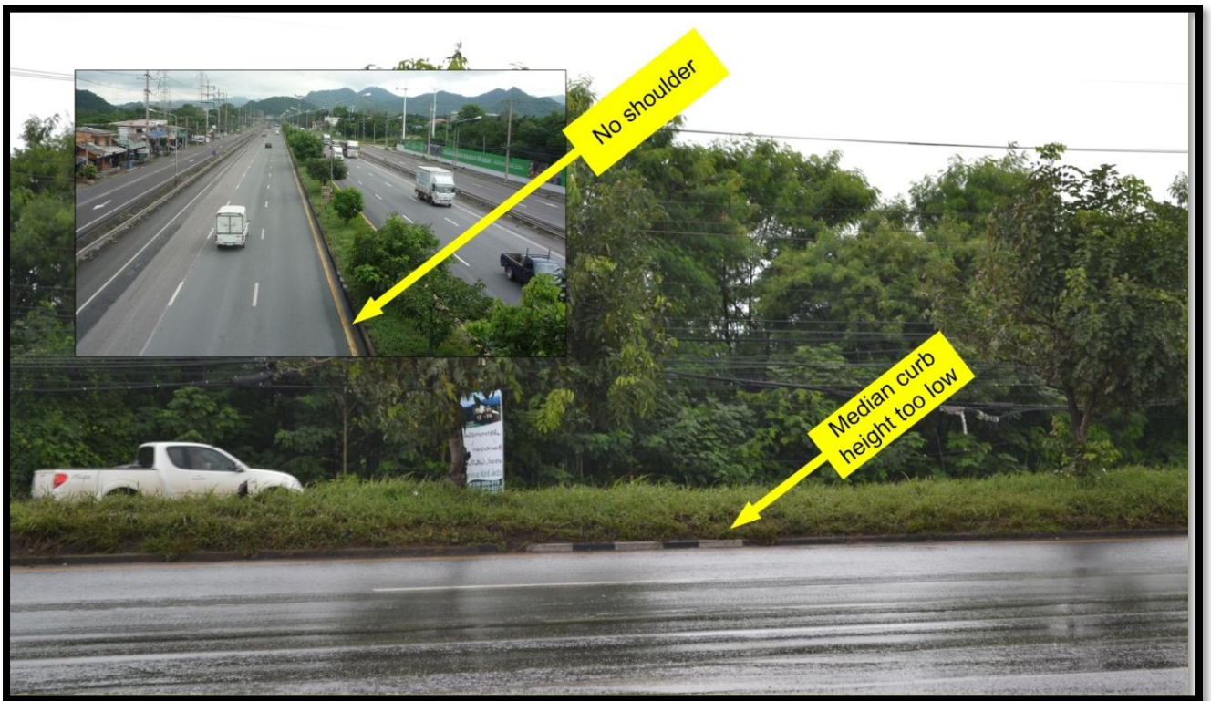
รูปที่ 21 ระยะไหล่ทางด้านขวาที่แคบมาก และขอบเกาะกลางที่ต่ำมาก
